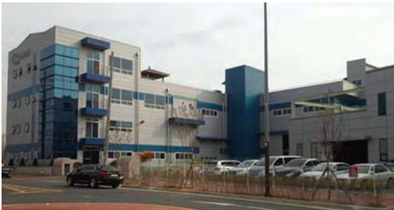
공 사 명 (주)오엠티 동탄공자 신축공사 주 소 화성시 동탄산업단지 공사기간 2013년 02월 ~ 2013년 06월
